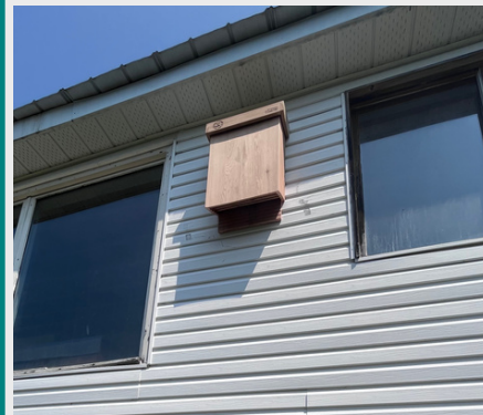
Abri à chauves-souris sur une maison PHOTO: FCF
